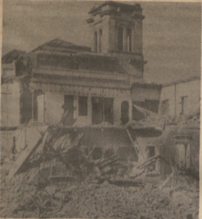
Então, em 1956, a Igreja foi demolida.
